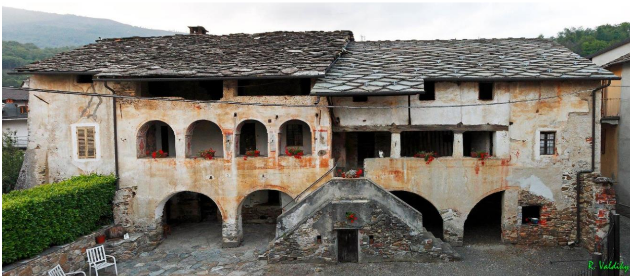
Vista della facciata principale.
