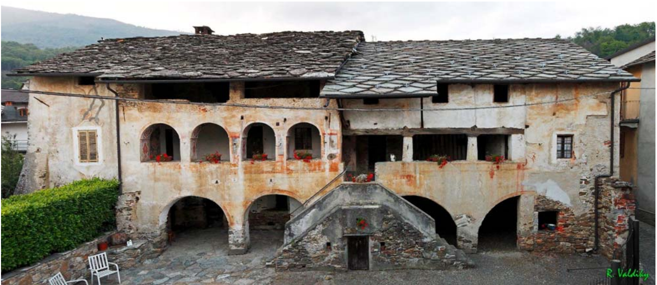
Vista della facciata principale.
